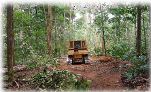
Abertura de estrada
